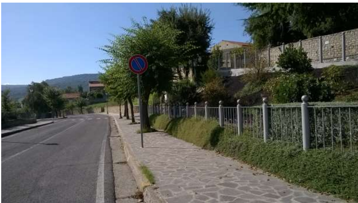
Via Roma - inizio tratto di intervento, zona piazzola laterale
