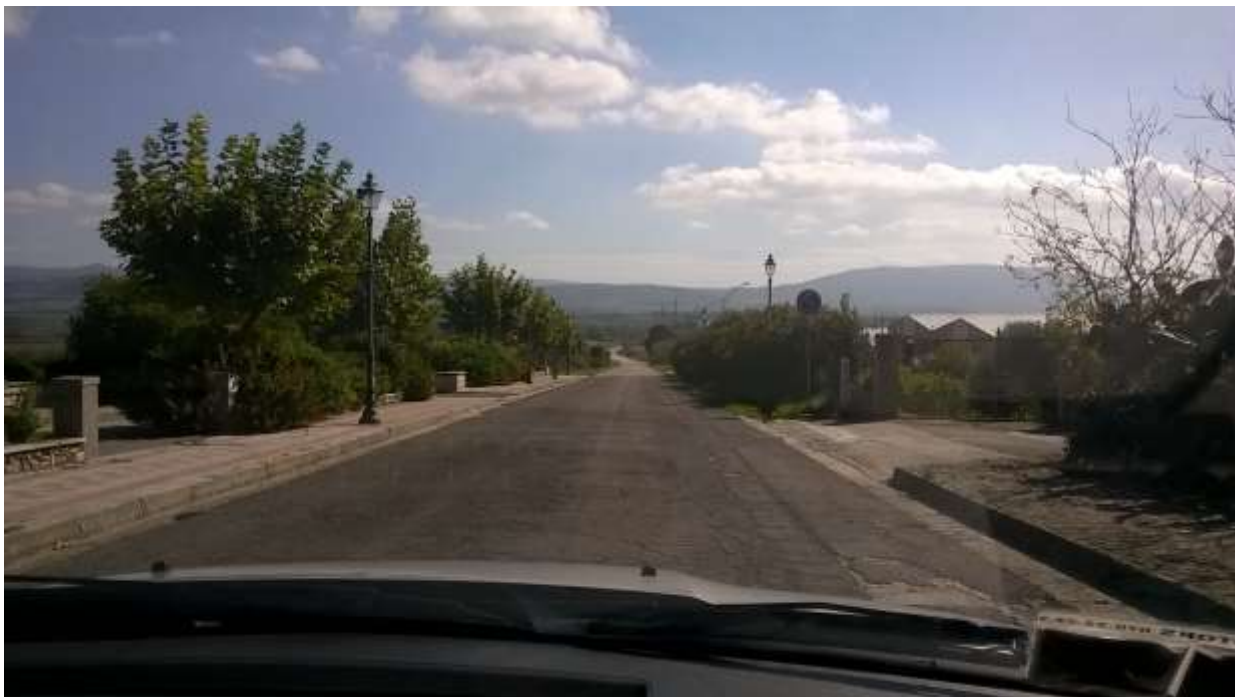
Via Roma direzione Nuragus - fine tratto di intervento
