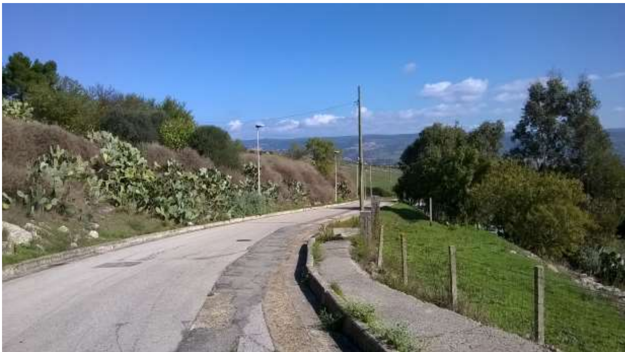
Via Paddiu direzione cimitero - inizio tratto di intervento
